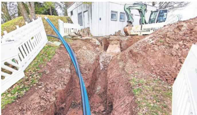
Neue Leitung (blau) vor dem Hochbehälter „Lettenbühl“
