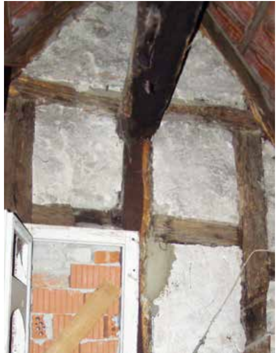
Die Unterfirstkonstruktion im Dachgeschoss
