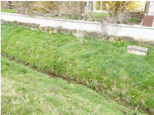
Abb. 11: Hochwasserschutzmauer mit vorgelagerten Natursteinreihe mit Spalten.
