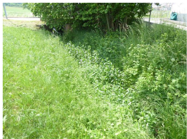
Abb. 8: Durchlassrohr Würm/Tübinger Straße im belaubten, dicht bewachsenen Zustand.
